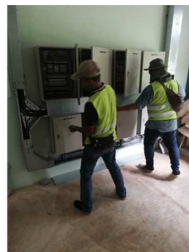
รื้อถอนอุปกรณ์ (DC/AC Combiner, Inverter, MDB, Battery)/ปรับปรุงระบบไฟฟ้า
