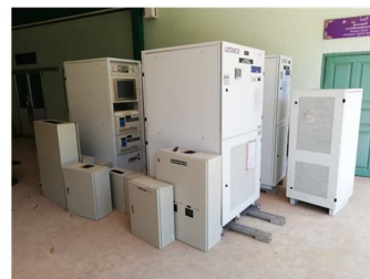
รื้อถอนอุปกรณ์ (DC/AC Combiner, Inverter, MDB, Battery)/ปรับปรุงระบบไฟฟ้า
