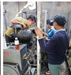
ซ่อมแซม Diesel generator
