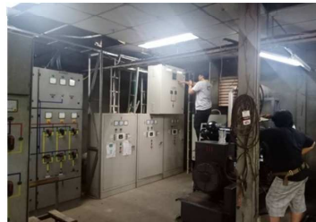
การติดตั้งอุปกรณ์ชุดใหม่ (DC/AC Combiner, Inverter, MDB, ATS)
