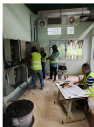
รื้อถอนอุปกรณ์ (DC/AC Combiner, Inverter, MDB, Battery)/ปรับปรุงระบบไฟฟ้า
