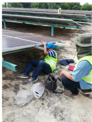
ตรวจสอบแผง PV และ wiring แผงใหม่ ให้เหมาะสม กับอินเวอร์เตอร์
