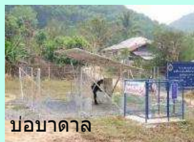
บ่อน้ำบาดาล งบประมาณ 709,345 บาท (กรมทรัพยากรน้ำบาดาล)
