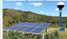
ชุดแผง Solar cell 3.2kWp (10 แผง)
